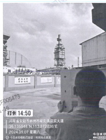
40MW发电锅炉排气筒出口
