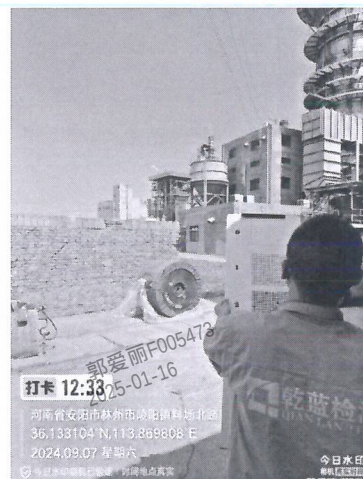
50MW发电锅炉排气筒出口
